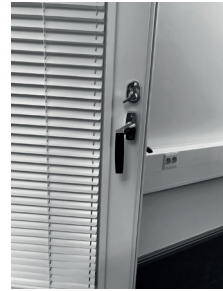
Ovi on varustettu tuulijarrulla ja jarrulaite lukkiutuu kääntämällä painike ala-asentoon
