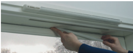
VÄLITILAN SUODATTIMEN IRROITUS / ASENUS
