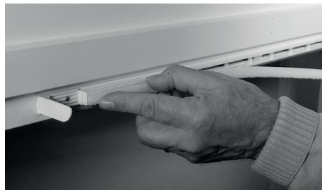
THERMOMAX VENTTIILIN SUODATTIMEN VAIHTO
