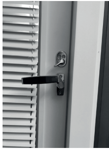
1. käännä lukitusnuppi auki-asentoon 2. käännä painike ylös asti ja avaa ovi
