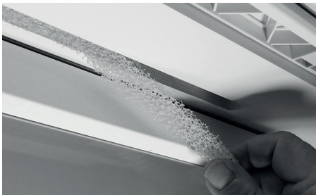
VÄLITILAN SUODATTIMEN IRROITUS / ASENNUS
